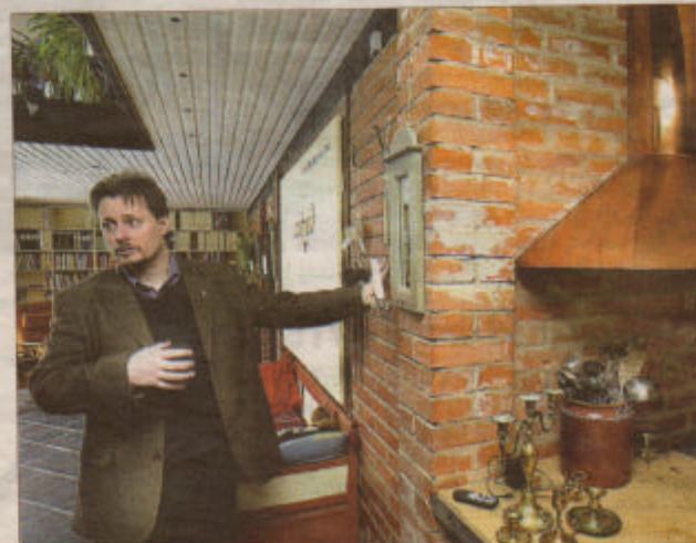
Tegelväggen mitt i huset hjälper till att utjämna temperaturskillnaderna.
